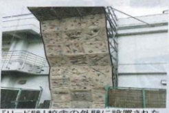
「リード壁」校舎の外壁に設置された、高さ1.1m、幅3mの壁
