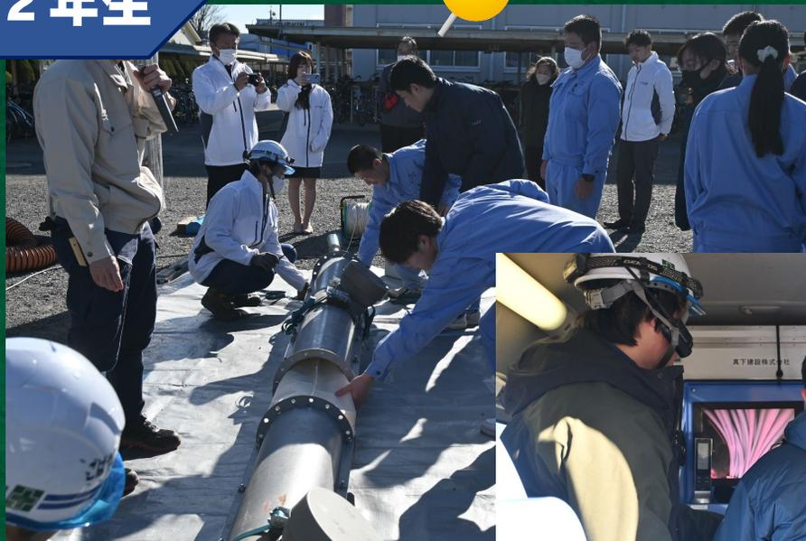
管渠の機能の維持・向上と、管渠の長寿命化対策として管渠の再生が進められています。光硬化工法協会の方々の御協力で、光を照射することによって管渠を更生する最新の管路更生工法を体験しました。
