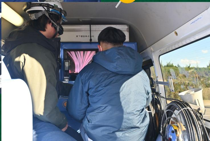
↑ TVカメラでライナー内部の異常有無を確認し、UV-LEDトレインを操作しています。
